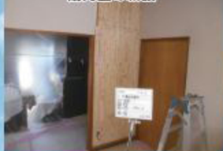
耐力壁の新設
